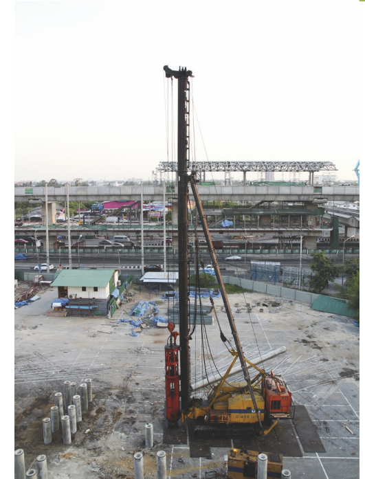
Figuur 44 De klap van een heiblok
